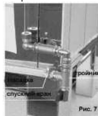
Вставьте силиконовый шланг в обе насадки на тройнике и закрепите их при помощи ленты (рис.8).
