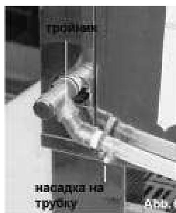
На правой стороне установите еще один тройник. Далее следует произвести монтаж спускного крана снизу тройника. Насадка шланга направлена в центр печи. См. рис. 7
