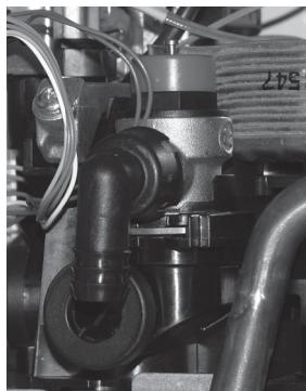
**Увага:** З'єднання на вхід газу до котла рекомендується ущільнювати шляхом закручення накидної гайки на передню частину штуцера з допомогою відповідної прокладки (див. документи котла ).
