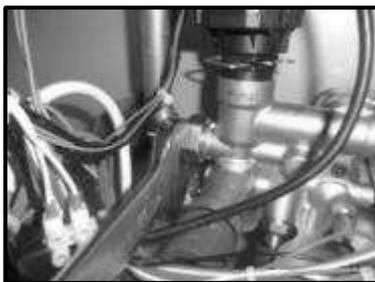
*Рисунок-25 Затягивание уходящей отопительной трубы с помощью гаечного ключа.*
