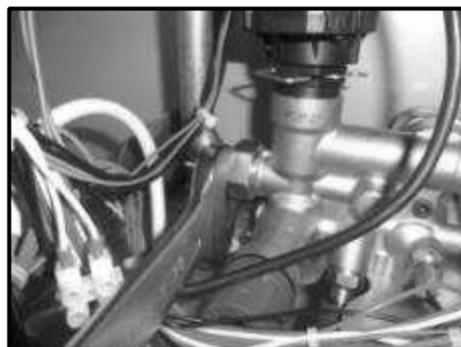
Рисунок-15 Затягивание приходящих и уходящих отопительных труб с помощью гаечного ключа.
