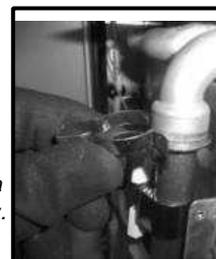
*Рисунок-23 Установка клипсы на уходящую отопительную трубу.*
