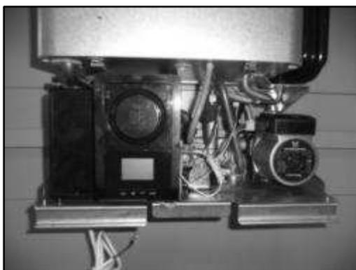
Рисунок-1 Установка контрольной панели на коробку основной платы
