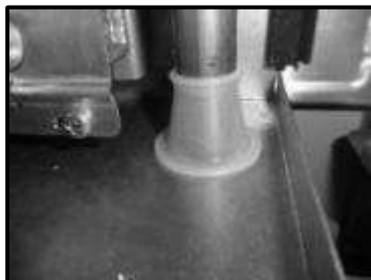
Рисунок-16 Установка пластмассового проходника для приходящей отопительной трубы.
