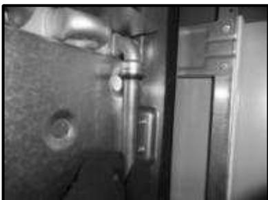
Рисунок-14 Установка приходящей отопительной трубы в главный теплообменник.
