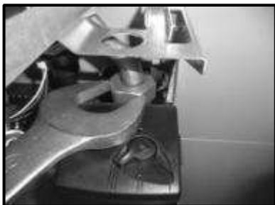
Рисунок-17 Затягивание приходящей отопительной трубы с помощью гаечного ключа.
