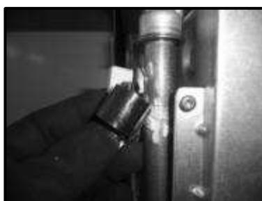
*Рисунок-7 Снятие термистора и ограничительного реле.*
