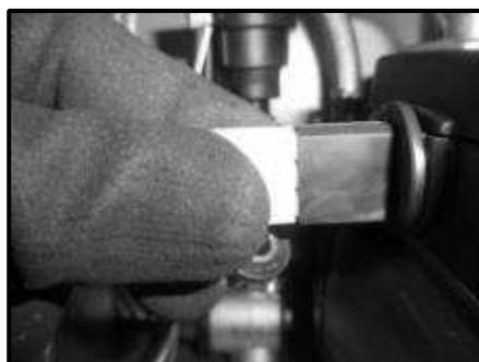
*Рисунок-8 Снятие приходящей отопительной трубы с помощью гаечного ключа.*
