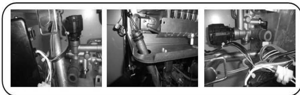
*Рисунок-21 Установка уходящей отопительной трубы.*
