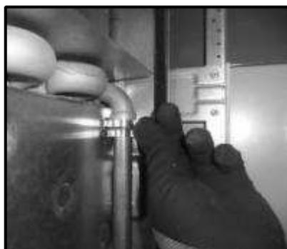
*Рисунок-6 Снятие клипсов уходящих и приходящих отопительных труб.*
