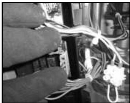
*Рисунок-24 Извлечение кабелей высокого и низкого напряжения из коробки*
