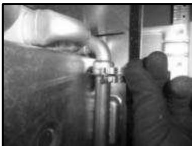
Рисунок-15 Установка клипса на приходящую отопительную трубу.
