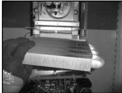
*Рисунок-11 Снятие главного теплообменника.*
