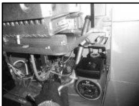
*Рисунок-10 Снятие приходящей отопительной трубы.*
