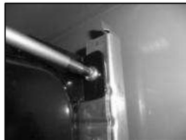
Рисунок-18 Затягивание верхнего винта расширительного бака.
