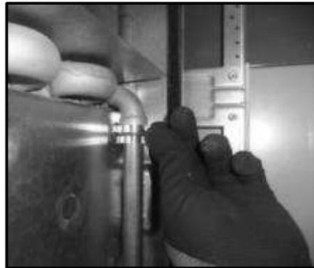
Рисунок-7 Снятие клипсов уходящих и входящих отопительных труб.
