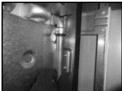
Рисунок-13 Установка приходящих и уходящих отопительных труб в теплообменник.
