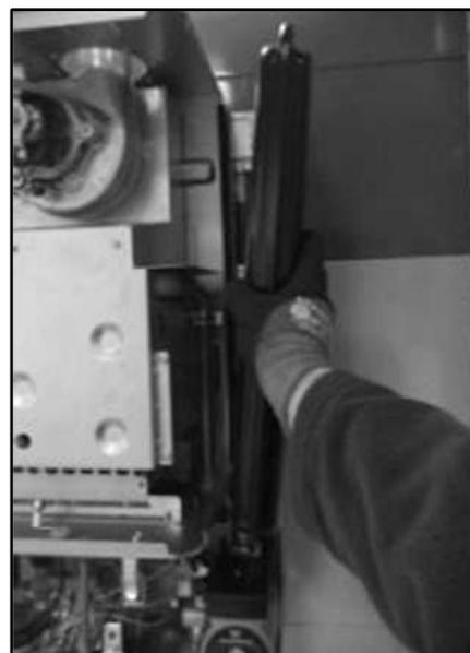
Рисунок-4 Снятие расширительного бака
