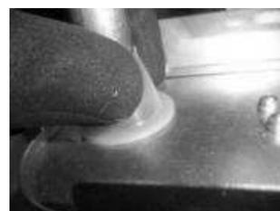
*Рисунок-24 Установка пластмассового проходника для уходящей отопительной трубы.*
