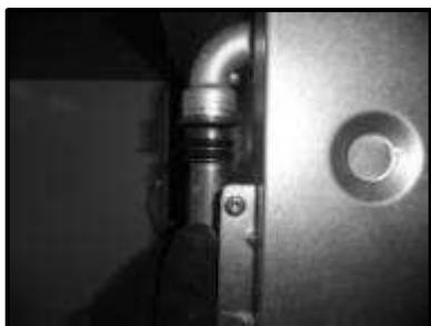
*Рисунок-22 Установка уходящей отопительной трубы в главный теплообменник.*
