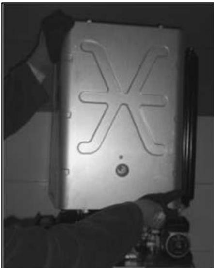
Рисунок-3 Снятие крышки герметического корпуса потянув на себя
