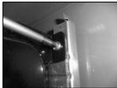
*Рисунок-19 Затягивание верхнего винта расширительного бака.*
