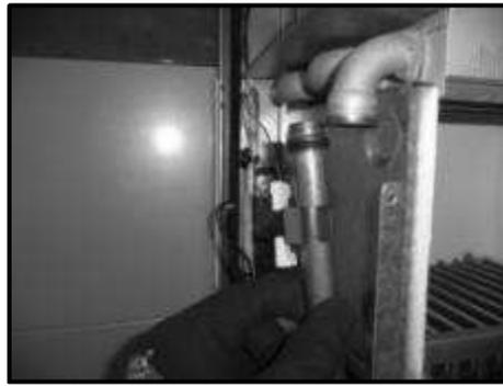
*Рисунок-10 Снятие уходящей отопительной трубы.*
