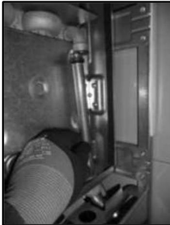
*Рисунок-9 Снятие приходящей отопительной трубы.*
