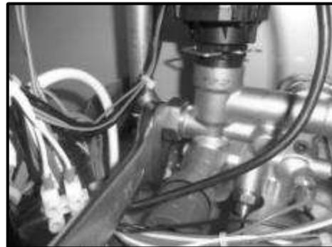
Рисунок-8 Снятие с помощью гаечного ключа уходящих и входящих отопительных труб.
