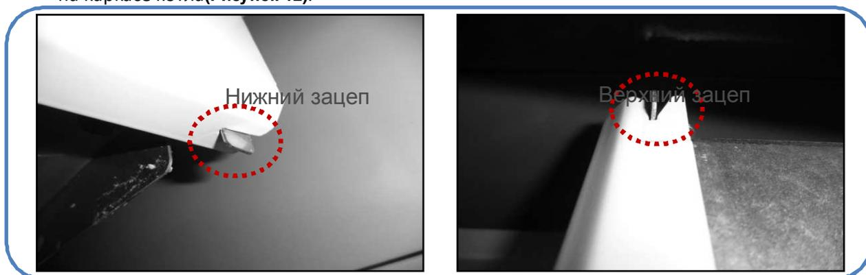
*Рисунок-12 Посадка передней крышки на зацепы, находящиеся на каркасе котла*
