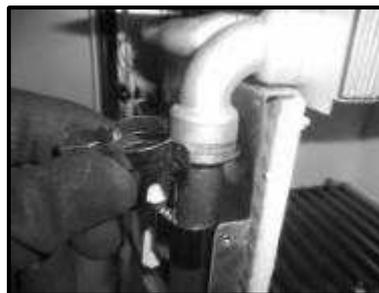
Рисунок-14 Закрепление клипсов на приходящих и уходящих отопительных трубах.
