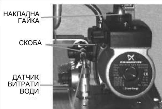
З'ЄДНУВАЛЬНИЙ КЛАПАН ПІДЖИВЛЮЮЧОГО ВЕНТИЛЯ
