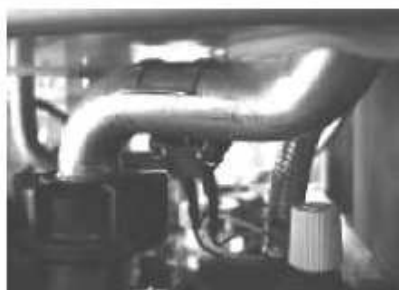
ДАТЧИК КОНТУРУ ЦЕНТРАЛЬНОГО ОПАЛЕННЯ
