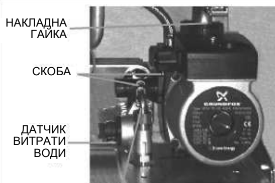
З'ЄДНУВАЛЬНИЙ КЛАПАН ПІДЖИВЛЮЮЧОГО ВЕНТИЛЯ
